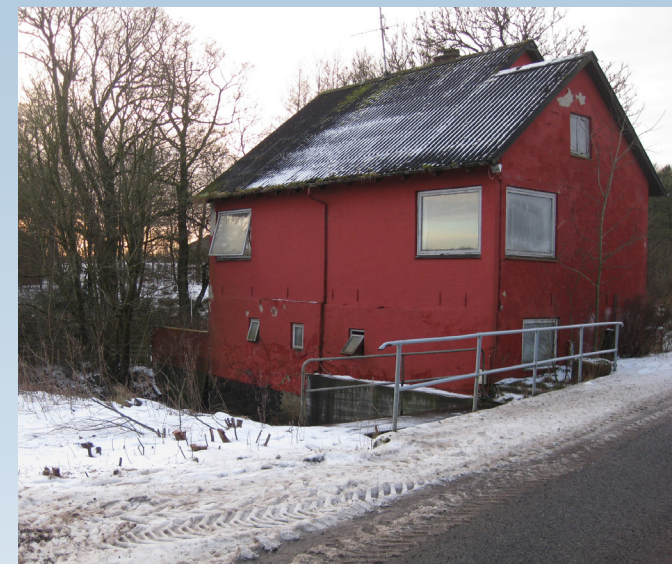
Møllehuset ved den tidligere vandmølle i Fåborg. Bygningen er fra 1940'erne, opført på møllehusets gamle sokkel i forbindelse med mølleriets omdannelse til dambrugsdrift. På den gamle sokkel ses endnu spor efter møllehjulet, der blev siddende mange år efter, at mølleriet var ophørt.
